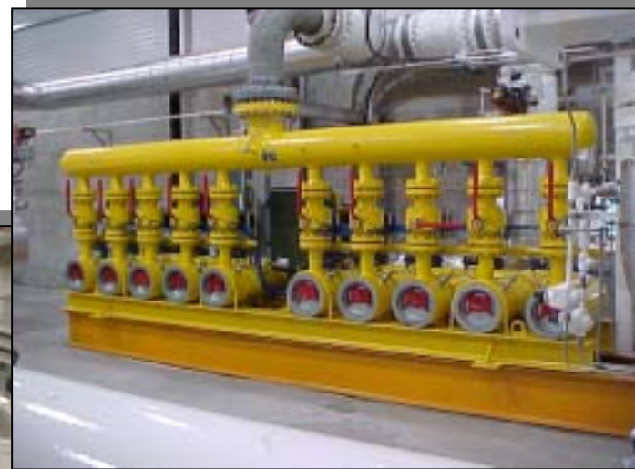
加拿大TCC高压天然气流量标准装置
